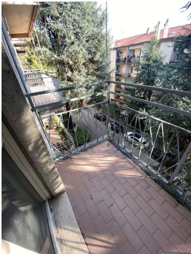
Foto 14/16 balconi e particolari pavimenti
